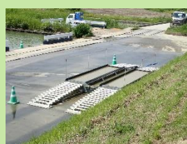
工事用車両のタイヤ 洗浄機の設置
