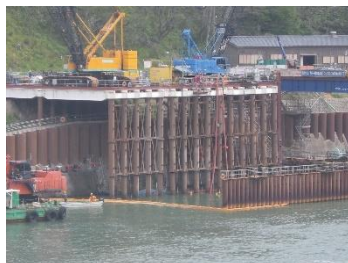
防音ハウスの設置
