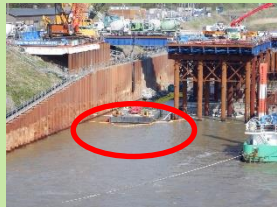
シルトフェンス (汚濁防止膜) の設置
