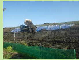
建設発生土を盛土 材料に利用
