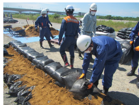
積み土のう工
