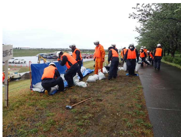
積み土のう工
