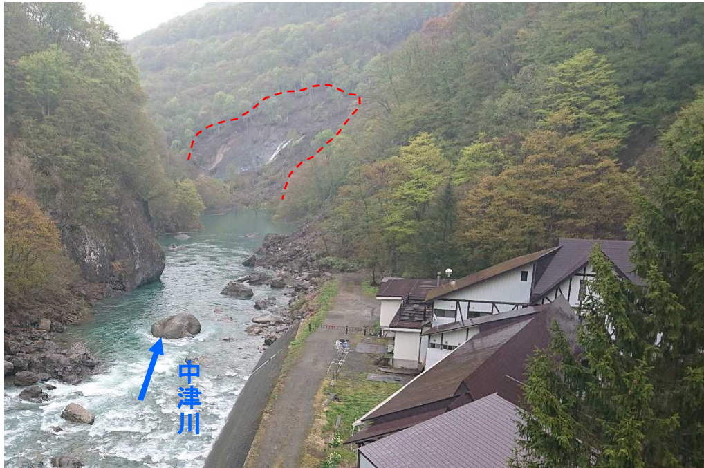
斜面崩壊の状況(上流側より撮影)
