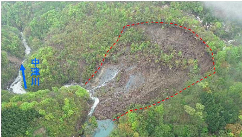
斜面崩壊の状況(UAVより撮影(栄村撮影))
