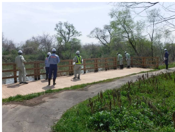
点検の状況(阿賀野川:新潟県)
