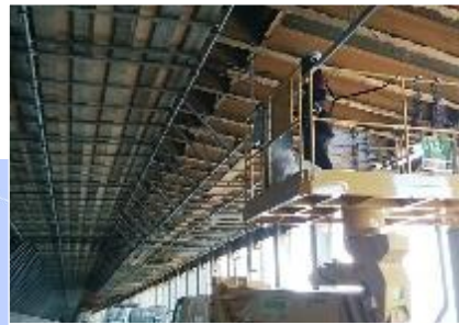
洞門内の梁部材補修状況
