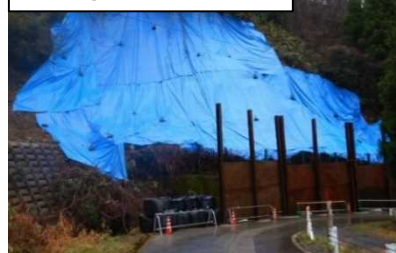
写真②(応急工事後)
