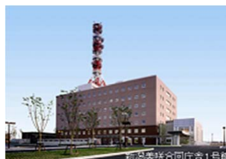
新潟美咲合同庁舎1号館
