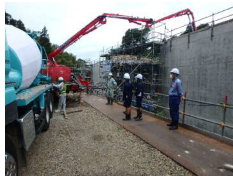
工事現場見学
