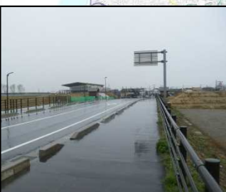
③瑞雲橋左岸(堤防高、堤防断面不足)
