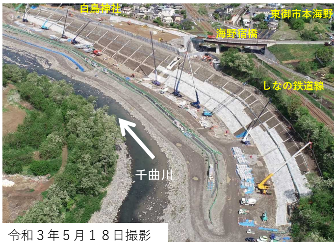
護岸再施工状況
