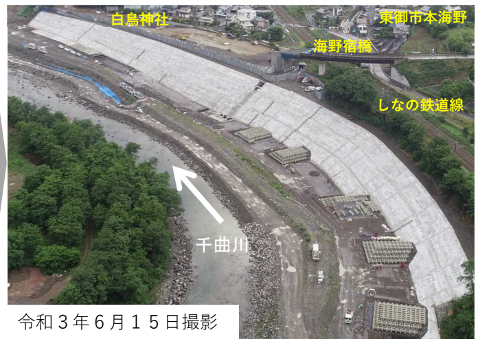
護岸再施工完了 (6/13完了)
