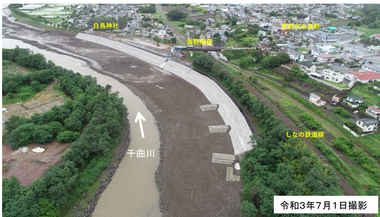
河道内工事完了状況
