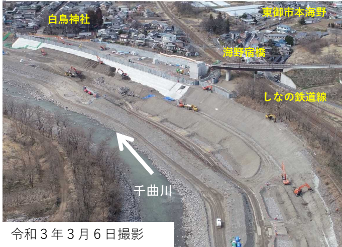
護岸再施工状況
