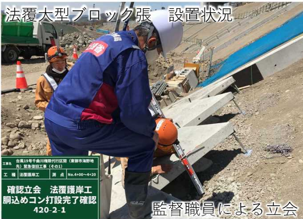
胴込めコンクリート 充填状況
