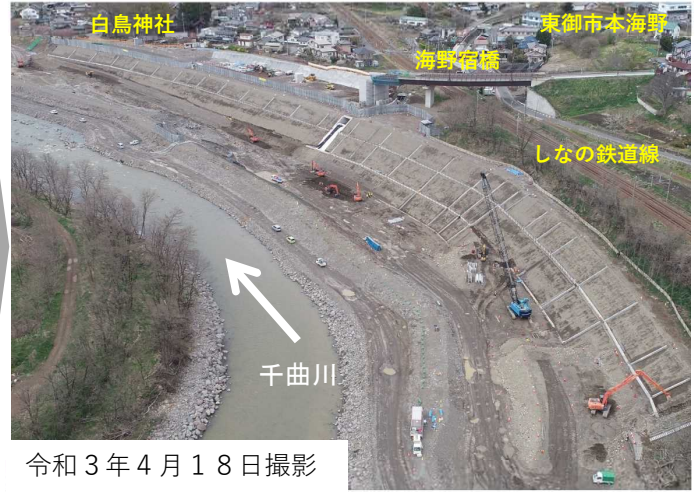
護岸再施工完了 (6/13完了)
