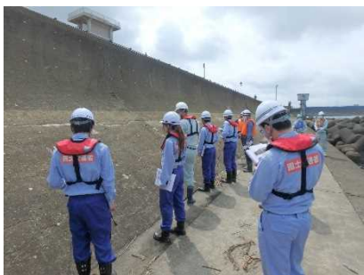
特殊堤の点検
