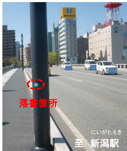
【写真】落書箇所（全景）
