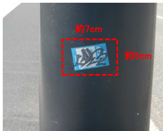
【写真】落書箇所（拡大）
