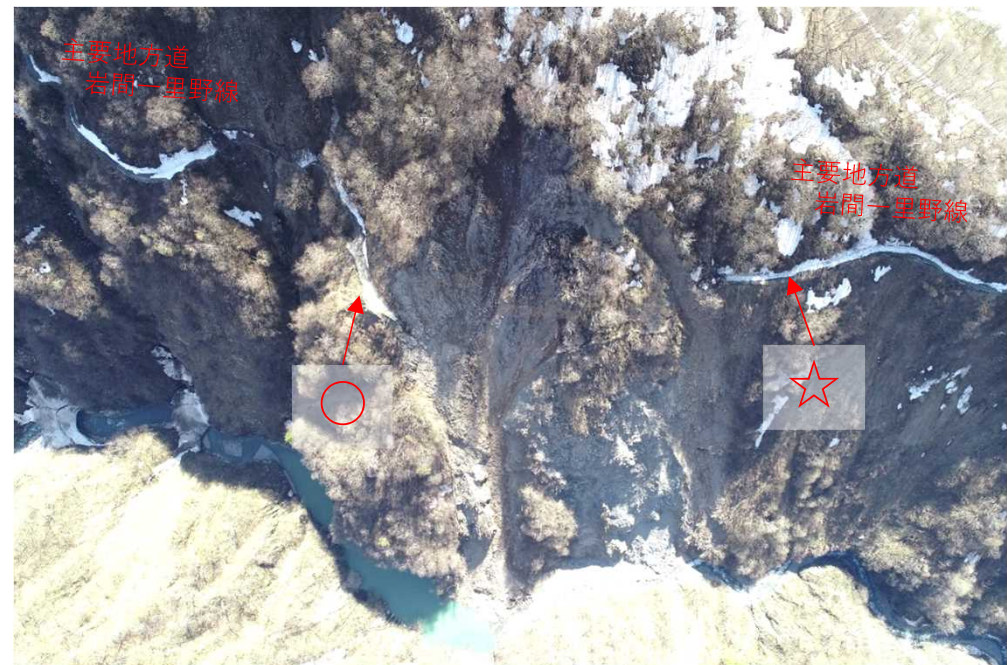
中ノ川崩壊後 上空写真 [R3.4.15撮影]
