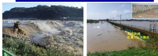
第二床固副堰堤付近の状況 (令和元年10月13日16時頃)
