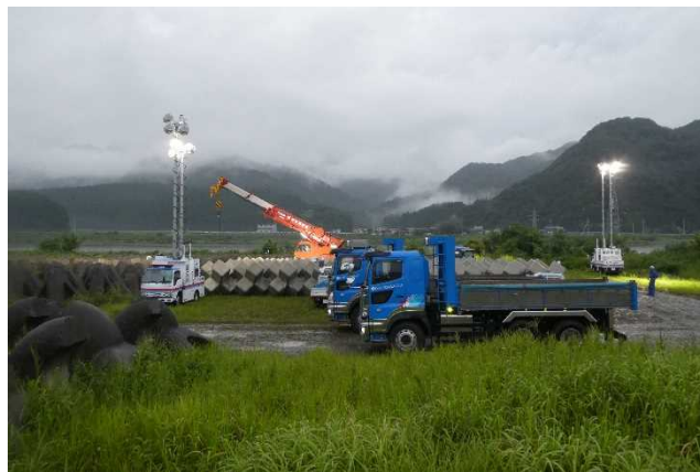
【ブロック搬出状況】
