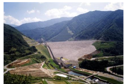
三国川ダム（新潟県南魚沼市）
