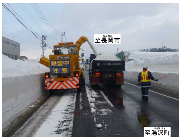
現道区間における運搬排雪作業状況 (令和3年1月撮影)
