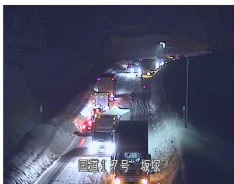
登坂不能車による交通障害(H30.2.12の様子)
