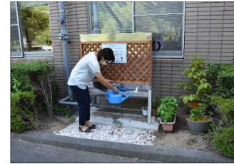
県有施設での雨水貯留タンク設置
