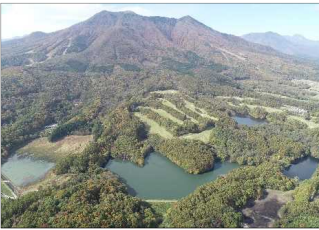
ため池を活用した雨水貯留
