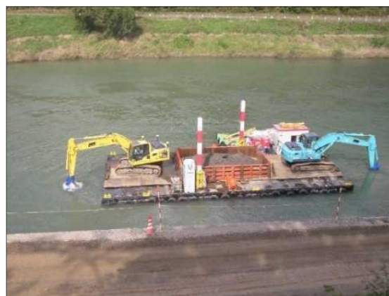
今後台船掘削による掘削を想定(例)【現在準備中】
