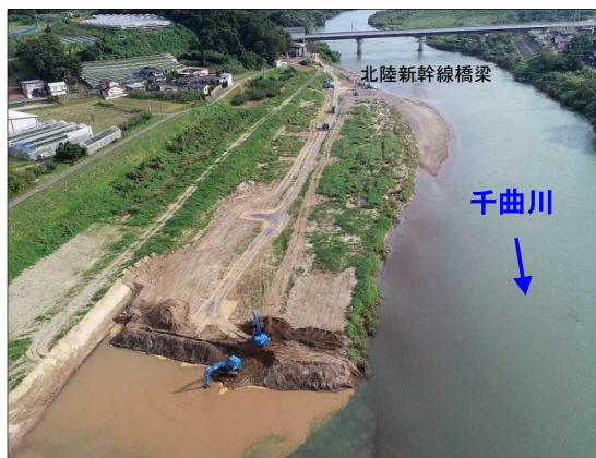
掘削作業状況
