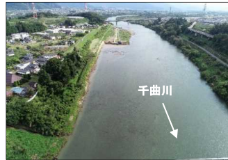
立ヶ花狭窄部の河道掘削
