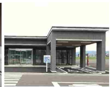
屋根付おもいやり駐車場
