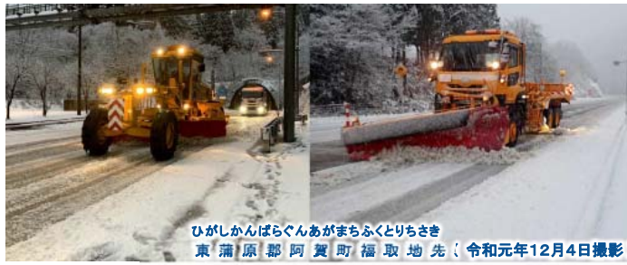
国道49号山間部の除雪
