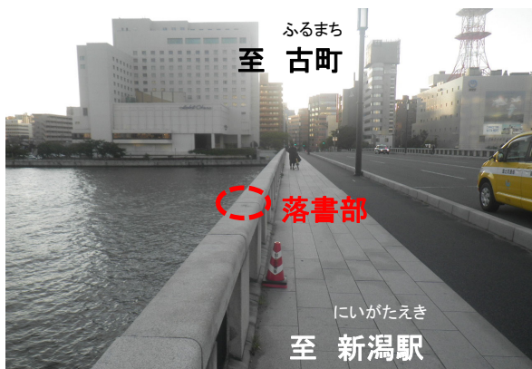
【写真】落書箇所(全景)
