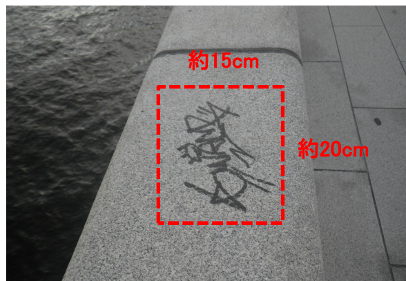
【写真】落書箇所(拡大)
