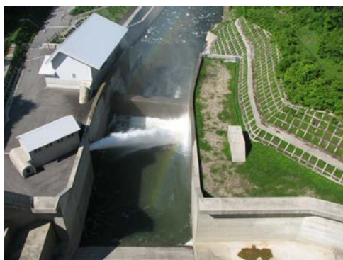
▲利水放流設備からの放流
