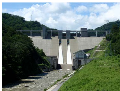
▲オリフィスゲートからの放流
