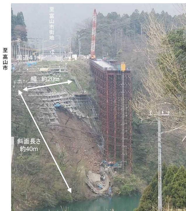
対岸より全景写真(➡撮影方向)
