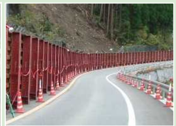
仮設防護柵工
