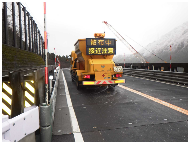
国道41号富山市片掛地先における作業状況
