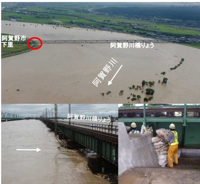
平成23年7月洪水時の阿賀野川橋りょう
