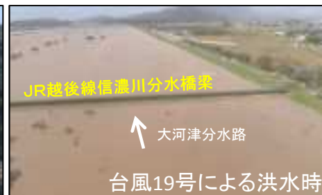
JR越後線信濃川分水橋梁
