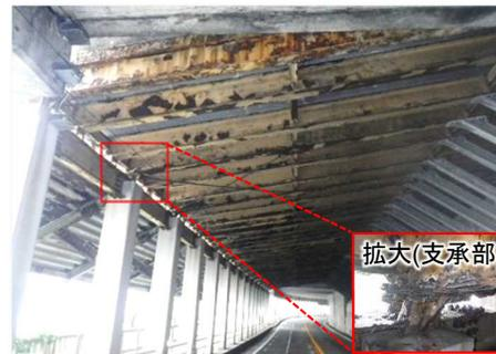
塩害による洞門鋼製部材の腐食
