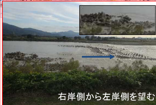
③29.4k渡場床固 床固流出
