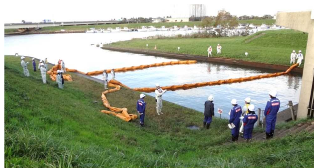
オイルフェンス設置
