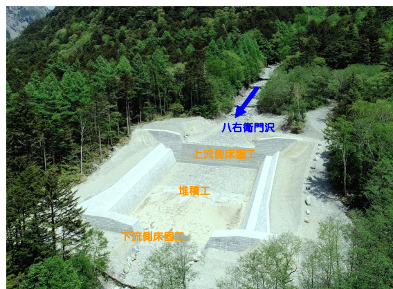
工事完成後(令和元年6月撮影)
