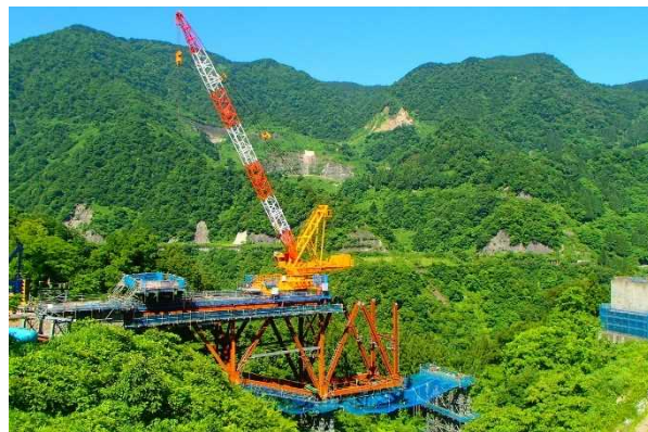
シクルビ谷の橋梁上部工事
