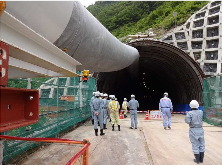
1号トンネル坑口(新潟側) H30. 5撮影
