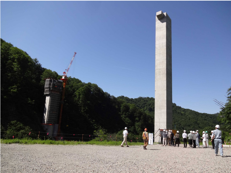
5号橋梁 P1・P2橋脚 R1. 5撮影
