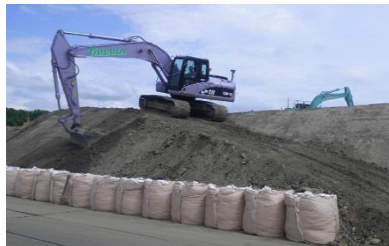
＜仮設搬入路の築造＞
