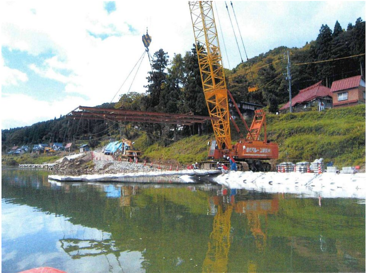
②100t級クローラークレーンによる連節ブロック吊落とし
