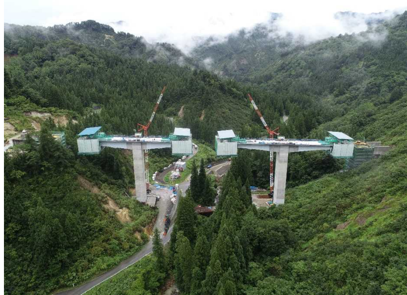
2号橋梁 張出架設 施工状況
