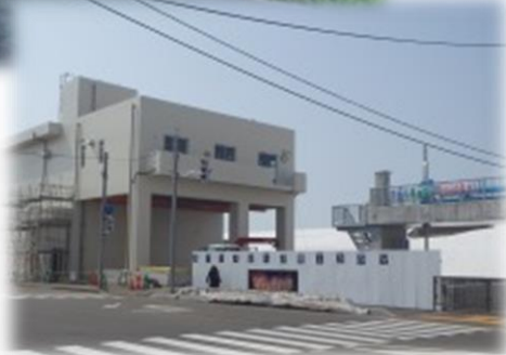
柿川放水路 排水機場
