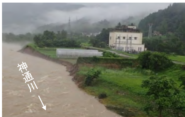
被災状況（平成30年7月7日 7時00分）
