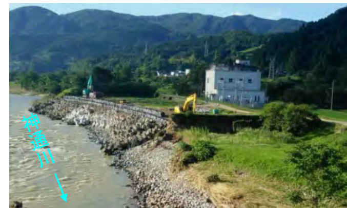
復旧状況（平成30年7月10日 7時00分）
