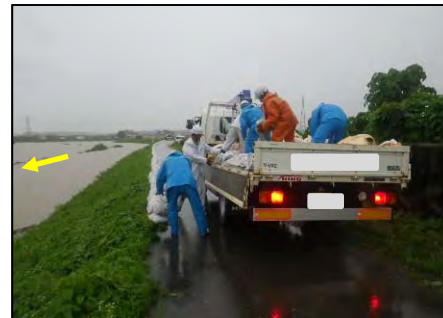
梯川左岸（佐々木町） 積み土のう工
