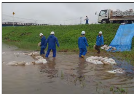
梯川左岸（荒木田町） 釜段工
