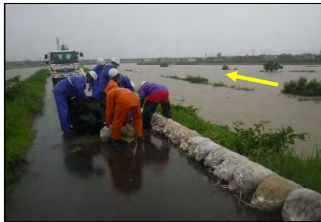
梯川左岸（佐々木町） 積み土のう工
