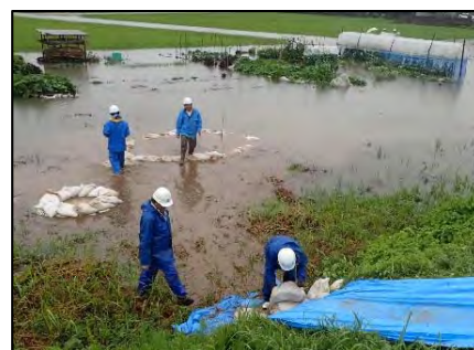
梯川左岸（荒木田町） 釜段工
