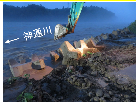
ブロック投入状況（平成30年7月7日 19時頃）
