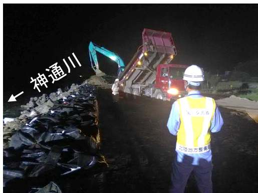
堤防復旧盛土施工状況（平成30年7月9日 21時頃）
