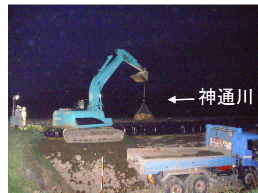
袋詰玉石設置状況（平成30年7月10日 20時頃）
