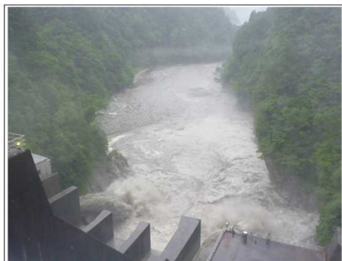
【出し平ダム下流】水位低下中(EL.315.65m) 6月28日 7:00撮影
