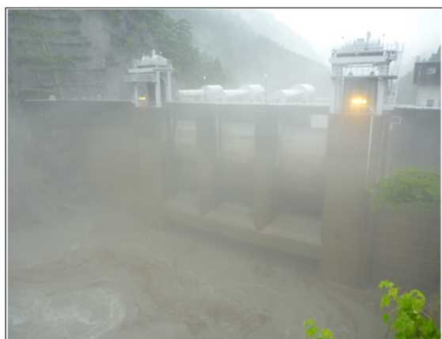
【出し平ダム排砂路呑み口部】水位低下中(EL.315.65m) 6月28日 7:00撮影
