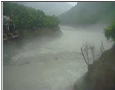
【出し平ダム湛水池】自然流下中(EL.308.55m) 6月28日 10:00撮影
