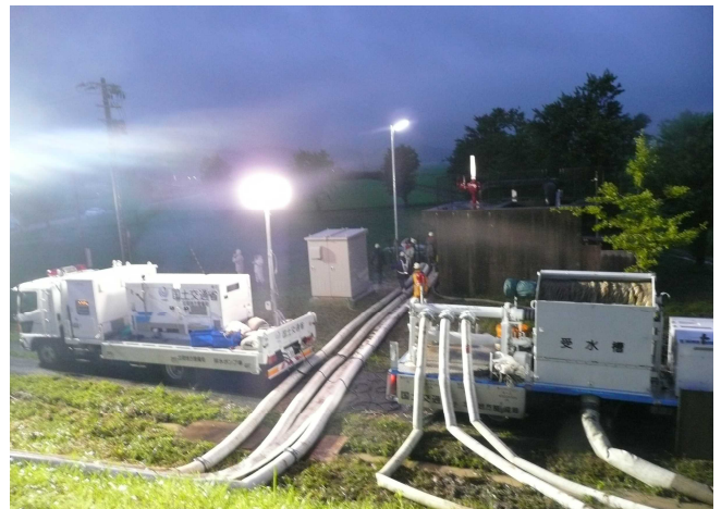
H23.7.29 加茂市下条下興野地先 排水ポンプ車出動・稼働状況
