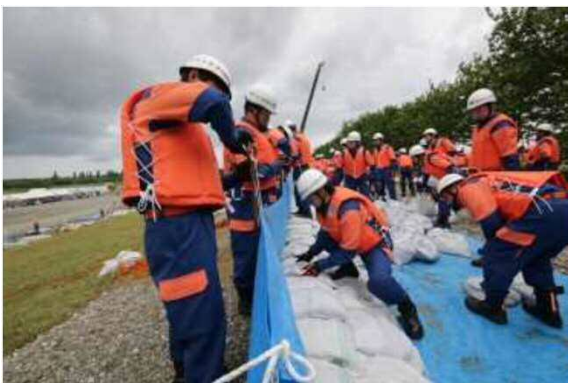
水防工法 【改良積み土のう工】
