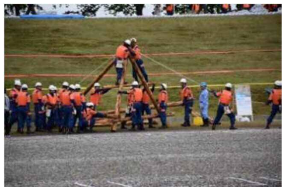
水防工法 【川倉工】
