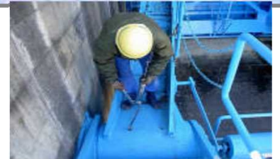
機械設備の点検
