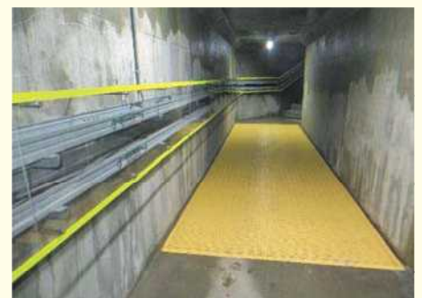
マット設置状況
