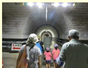
大町ダム内部見学
