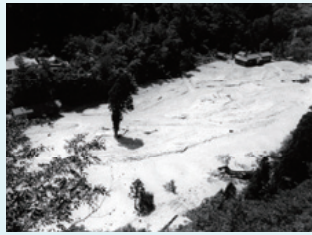
昭和44年高瀬川水害の被害状況
