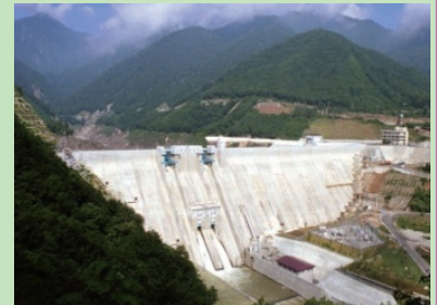
大町ダム建設事業 完了 S61.3
