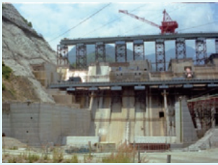
大町ダム建設当時の様子
