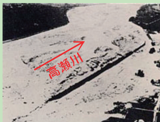
堤防決壊で氾濫する高瀬川（松川村細野） S44.8
