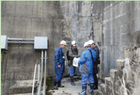
ダム本体のひびわれ状況調査
