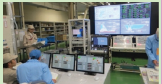
新しいダムコンの工場試験状況 (平成27年11月25日)
